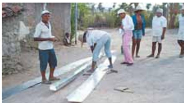
Capacitação em construção de cisternas – aqui das calhas para a captação da água da chuva – para mulheres na comunidade de Brasa, Teofilândia.
