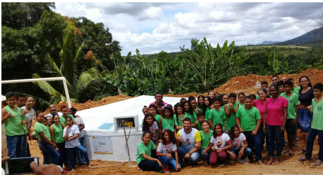
Projeto Cisterna nas Escolas do Município de Pindobaçu da Comunidade de Fumaça
