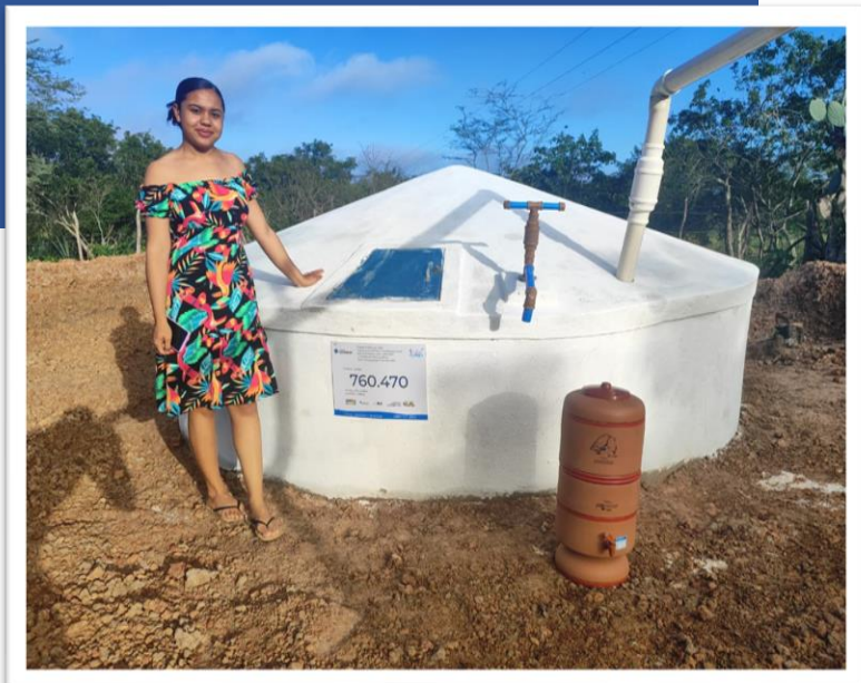
Família contemplada com tecnologia social de captação e armazenamento de água da chuva para consumo humano, comunidade de
